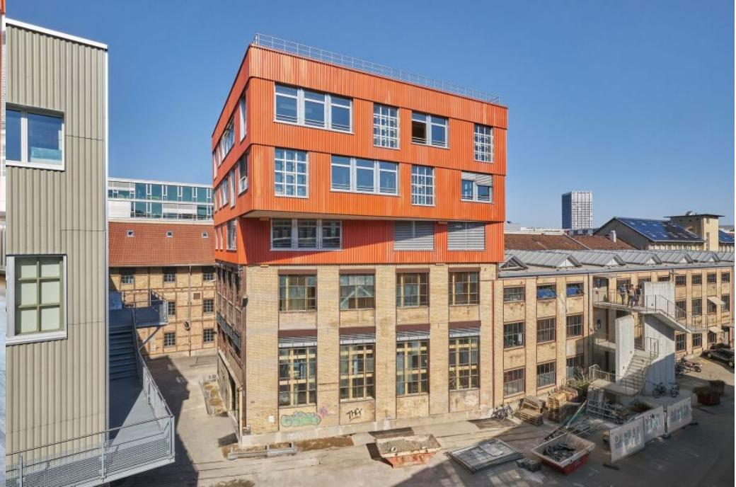
baubüro insitu ag, circular straw insulated addition <https://www.insitu.ch/projekte/196-k118-kopfbau-halle-118>
